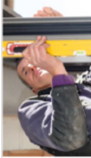
14 CONTROLLARE ANCORA L'ALLINEAMENTO DELLA FINESTRA
