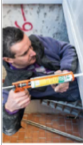
11 MONTARE IL DAVANZALE FINESTRA ESTERNO
