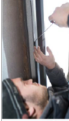
12 APLICARE IL NASTRO ISOLANTE
