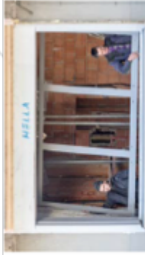
13 INSERIRE IL TELAIO FINESTRA
